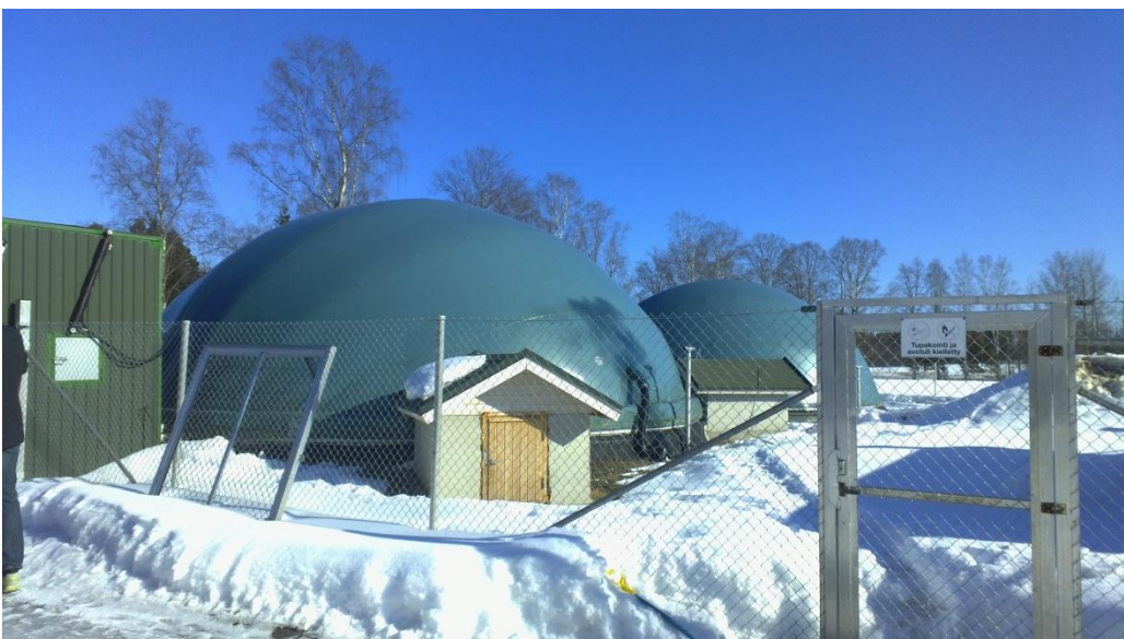
Kuva 2 Maaningan MTT:n biokaasureaktori ja jälkimädätysallas.
