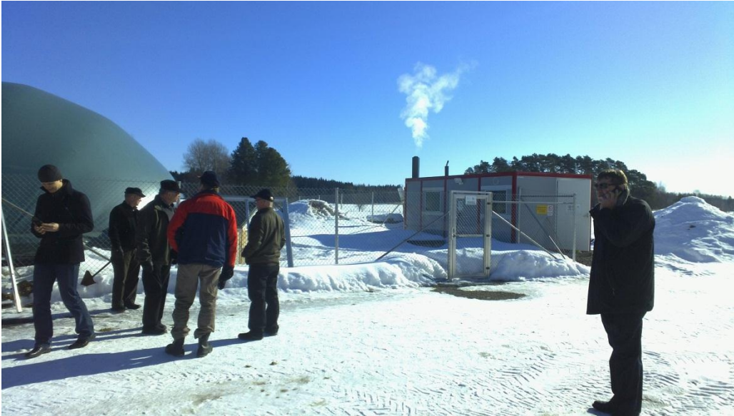
Kuva 3 Oikealla CHP laitosyksikkö.
