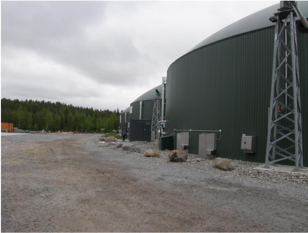
Kuva 5 yllä: Mädätyskammiot Jepuan laitoksella Kuva 6 alla: Lämmönvaihtimet, jotka ottavat talteen lämpöä hygienisointiprosessista ja jolla lämmitetään kaasukammioita.
