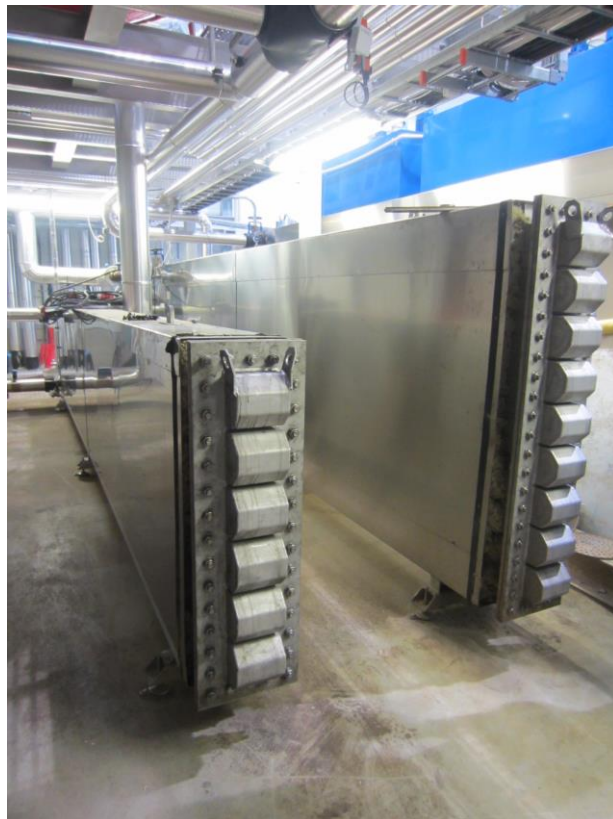
Kuva 5 yllä: Mädätyskammiot Jepuan laitoksella Kuva 6 alla: Lämmönvaihtimet, jotka ottavat talteen lämpöä hygienisointiprosessista ja jolla lämmitetään kaasukammioita.
