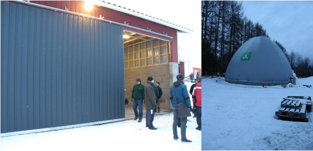
Kuva 6 Vasemmalla: separoinnin jälkeen mädätysjäännöksen kuivajae varastoidaan tähän varastoon. Oikealla: kaasukupu, jonka alla on varasto nestejakeelle.
